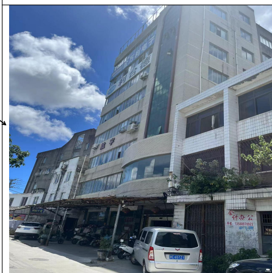
南侧：浙江琦美电气有限公司
