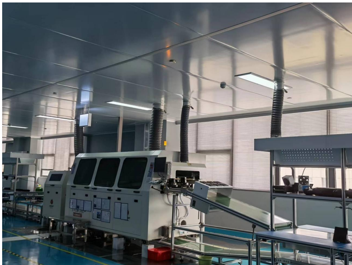
波峰焊车间集气照片
