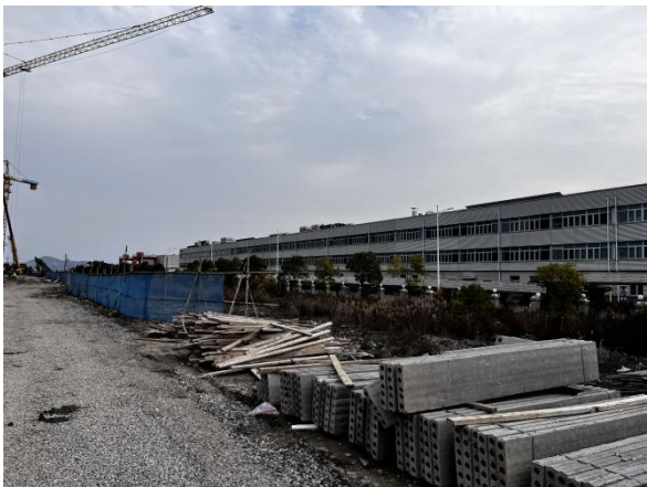
项目西南侧现状
